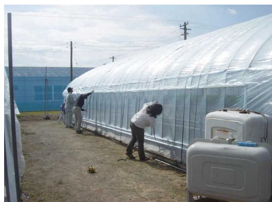
ビニールハウスの張り替え
